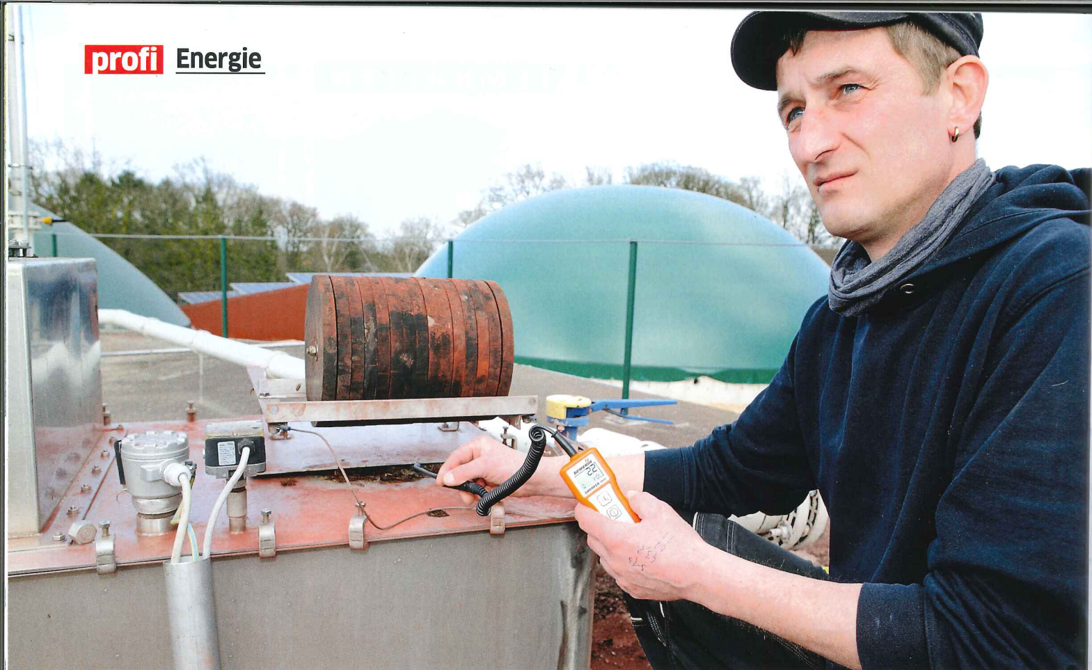
An jedem Ort das Geschehen auf einer Biogasanlage fest im Visier: Mit seinem Wissen unterstützt Andreas Bloß Betreiber einer Biogasanlage – im Idealfall nicht immer erst im Ernstfall. Fotos: Zäh
